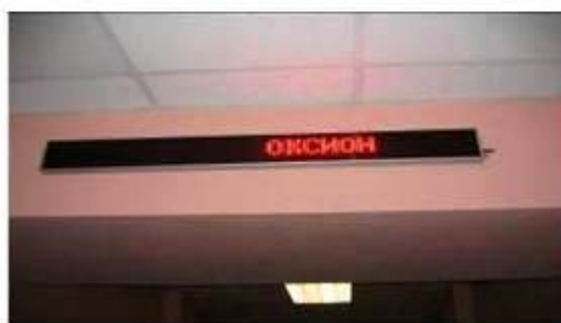
Устройство типа «бегущая строка» в административном здании
